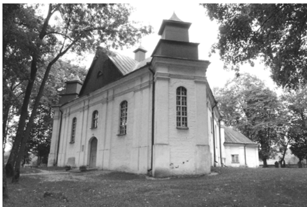
Fig. 16. Poniewieżyk (Panevežiukas), Żmudź, kościół p.w. Jezusa Ukrzyżowanego, 1747. Fot.: J.K. Lenartowicz. Poniewieżyk (Panevežiukas), Samogitia, Lithuania, church of the Crucified Jesus, 1747. Photo: J.K. Lenartowicz.
