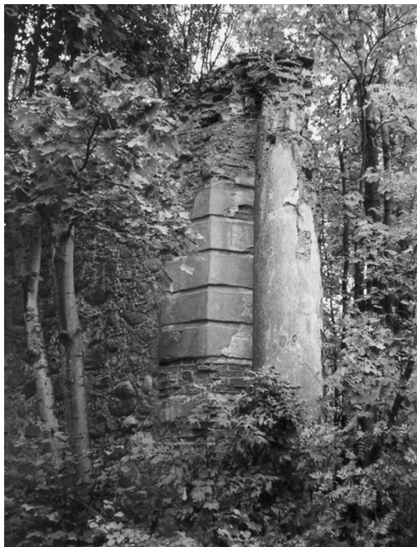
Fig. 25. Sworotwa Wielka, murowana cerkiew św. Trójcy, 1823. Kolumna w narożniku południowym. Stan 2002. (Fot. K. Lenartowicz). Greater Sworotva. Holy Trinity's Uniate church. 1823. The column in the south vertex. State as of 2002. (Photo: J.K. Lenartowicz).
