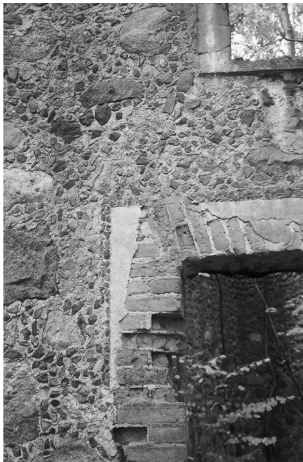
Fig. 21. Sworotwa Wielka, murowana cerkiew św. Trójcy, 1823. Obramienia otworów. Stan 2002. (Fot. K. Lenartowicz). Greater Svorotva. Holy Trinity's Uniate church. 1823. The surrounds of the openings. State as of 2002. (Photo: J.K. Lenartowicz).
