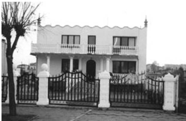
Ryc. 20. Willa w typie modernistycznym. Prosta bryła budynku z falistą attyką [Kłodawa X].
