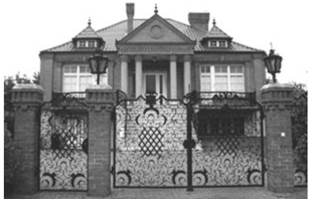
Ryc. 16. Willa w typie dworowym. Na osi budynku, w linii wejścia umieszczono portyk kolumnowy zakończony przyczółkiem [Kalisz II].
