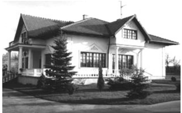
Ryc. 17. Trzy portyki kolumnowe w układzie osiowym nawiązują do wzorów palladiańskich [Kłodawa III].
