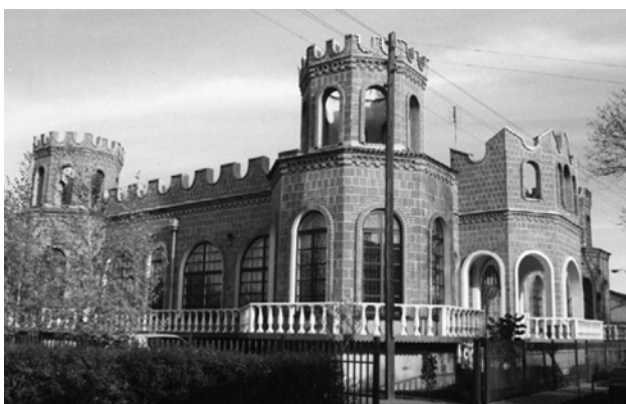
Rys. 8. Budynek w typie zamkowym [Kłodawa I]. Widoczne charakterystyczne narożniki w formie wież oraz attyka przypominająca blanki. Przyjęte oznaczenia budynków np. [Kłodawa I] przyjęte wg. katalogu willi Romów.
