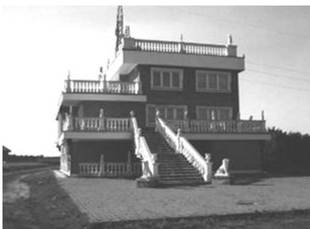
Ryc. 21. Grzebieniowa balustrada z tralek jednolalkowych oraz reprezentacyjne schody wejściowe stają się elementami dominującymi [Września I].
