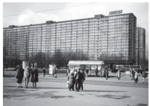
Spółdzielczy normatyw mieszkaniowy polegał głównie na geometryzacji przestrzeni życiowej człowieka. Absurdalność wyliczeń minimalnego normatywu mieszkalnego polegała na tym, że za życia człowiekowi przysługiwało mniej powierzchni niż na cmentarzu.
