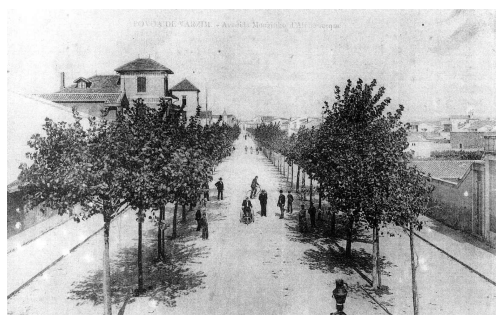
Fig. 16. Avenida Mouzinho de Albuquerque, około roku 1900. Przy tej alei prostopadłej do wybrzeża i zorientowanej na południe znajdują się rezydencje takie jak Vila Miosótis oraz Vila Georgete, wszystkie po tej samej stronie alei. Ich główne fasady są zwrócone na południe (a więc w kierunku morza). Widokówka z Muzeum Etnograficznego w Póvoa de Varzim.
