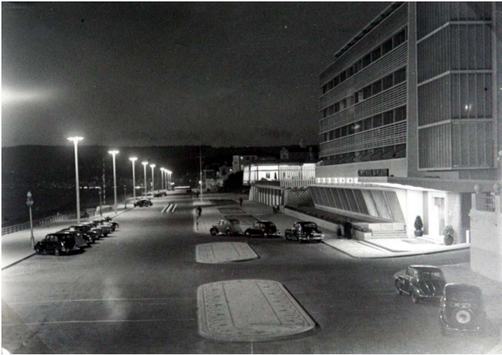
Fig. 97. Grande Hotel w Figueira da Foz, projekt: Inácio Peres Fernandes w 1950, Archiwum Miejskie w Figueira da Foz, Museu Santos Rocha.
