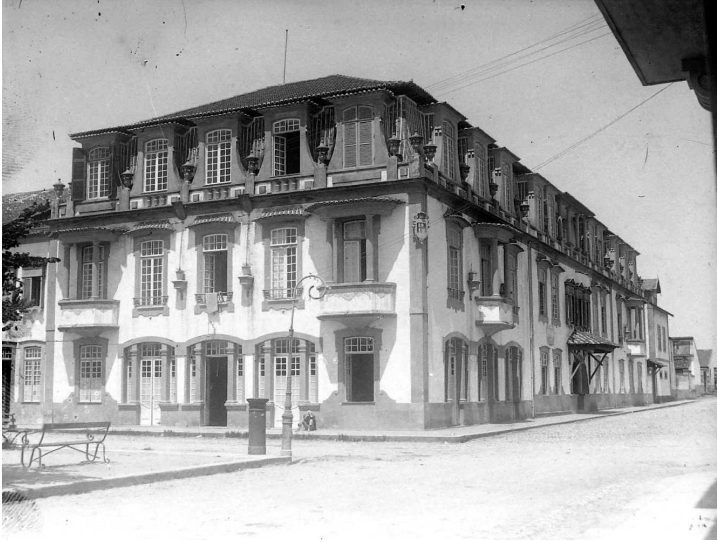
Fig. 66. Pałac Hotel de Vila do Conde. Wzniesiony przypuszczalnie na początku wieku XX. Potem zmieniany. Znajdują się odniesienia do prac z roku 1946 podjętych przez Júlio Freire Temudo Barate, inżyniera, i w roku 1959 przez architekta Meira Bensusana, który mu nadał dzisiejszy wygląd. Archiwum Miejskie w Vila do Conde.
