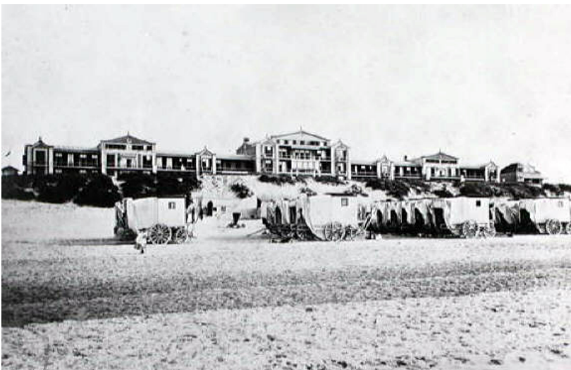
Fig. 108. Scheveningen, Hotel "Garni", z potężnym zespołem kabin łaźniowych, z kołami i nasuwanymi budami, ustawionymi na przedzie, na plaży. Fotografia z początku wieku XX. Arquivo Municipal de Haia.
